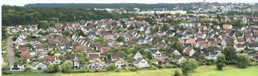
„Der Sand“, Baubeginn 1935 (Foto Stadtarchiv), 2021, die heutige Ausdehnung
